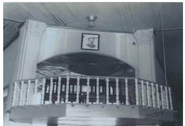
Plataforma interior (en segunda planta), donde se pronunciaban los discursos del casino
