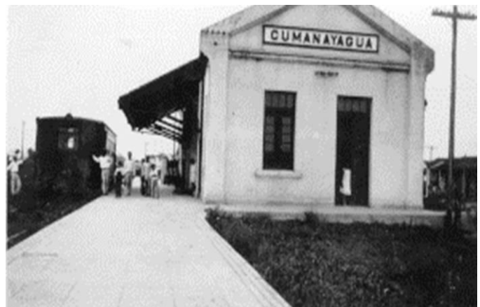
Terminal de ferrocarriles
