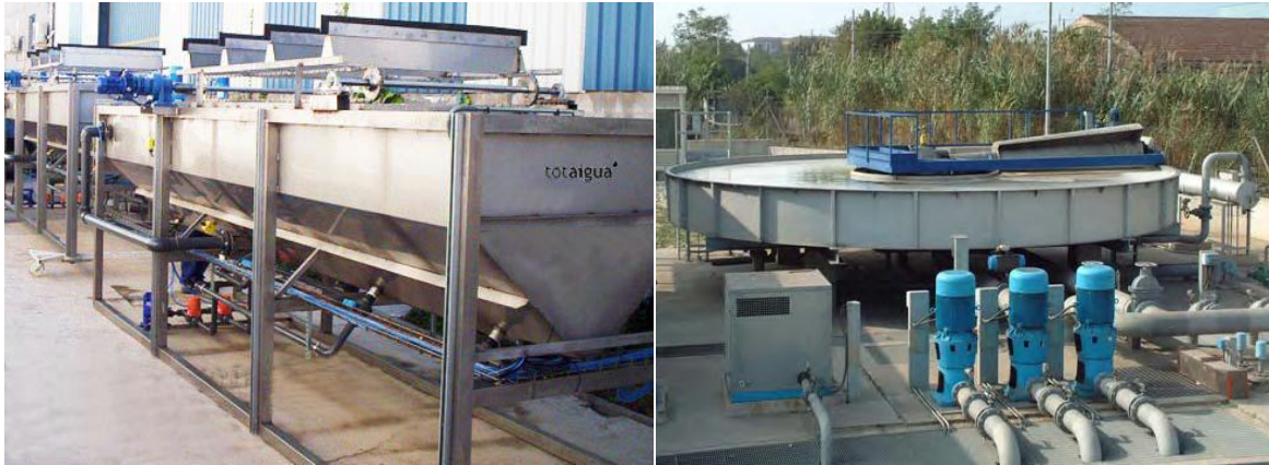
Figura 4. Tipos de flotadores por aire disuelto.
