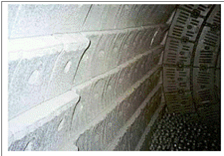
Figura 3.11 Forros de Blindaje Tipo Monostep nuevos y desgastados en la misma cámara. (Fuente: Polysius Cemento, 2013)
