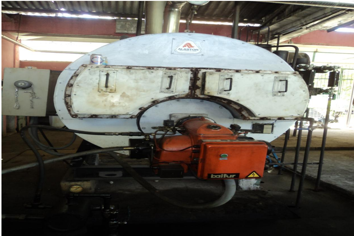
Figura 2.3. Instalación de las calderas de la UCF.
